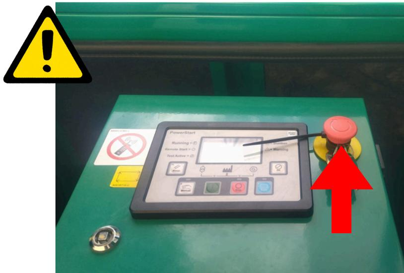
En caso de emergencia presione el botón rojo para detener el funcionamiento de la planta eléctrica.
