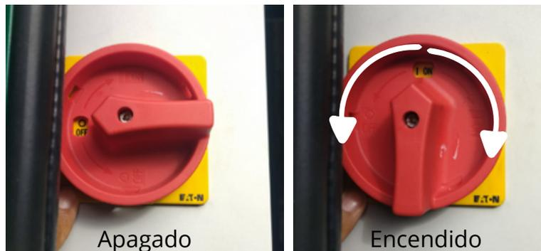
2-. Una vez encendido el selector de voltaje, se procede a presionar los botones correspondientes ubicados en el tablero de control.
